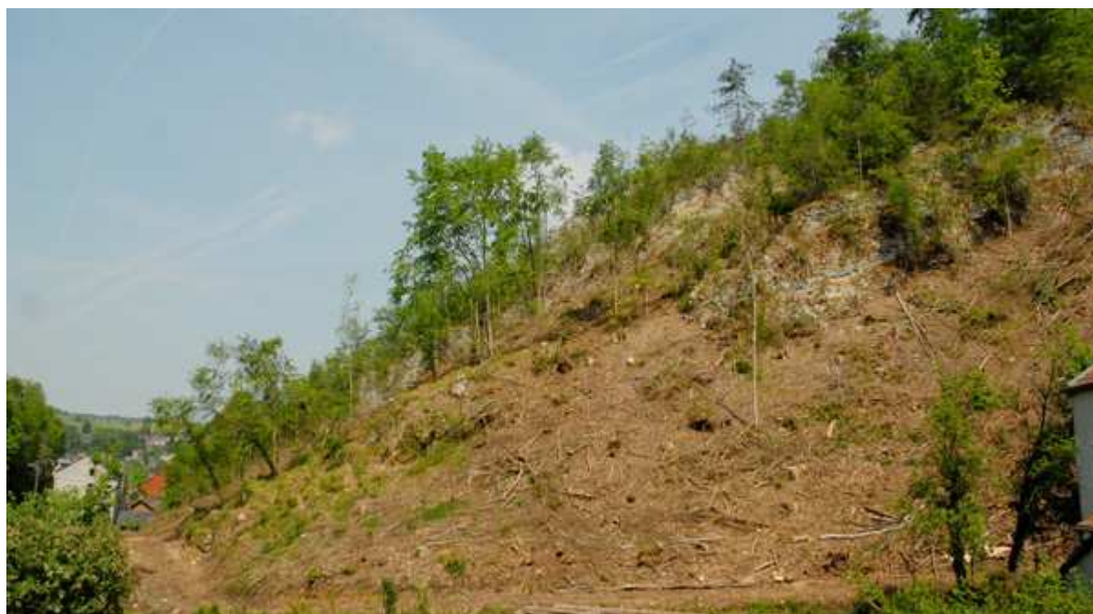
Vue des rochers pendant les travaux de remise en lumière. L'ensemble du site était occupé par une vaste pinède jusqu'il y a peu.
