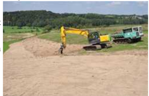
De colossaux travaux d'étrépage sur plusieurs hectares
