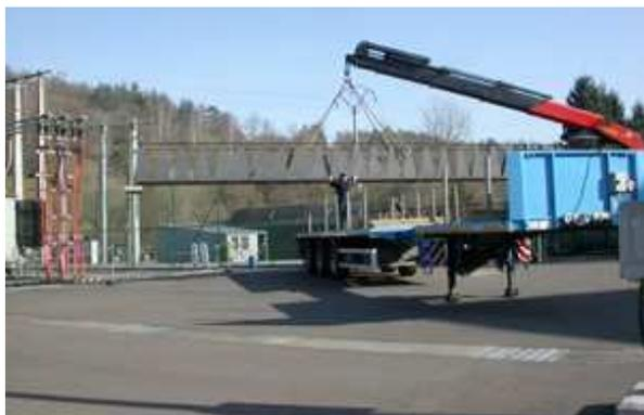
Une seule solution dès lors : entrer dans le poste électrique et soulever la passerelle au-dessus de la clôture d'enceinte pour accéder à la servitude au-delà du fameux virage. Ce fut chose faite et à 9h30, portée par une grue, la passerelle s'avançait au-dessus de l'eau, telle une soucoupe volante.
